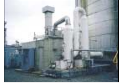
Fig 37. VOC 제거 열화수형 촉매연소 장치 (SKICO-REC)
