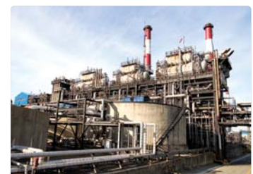
III 사진 13_열병합 발전시설
